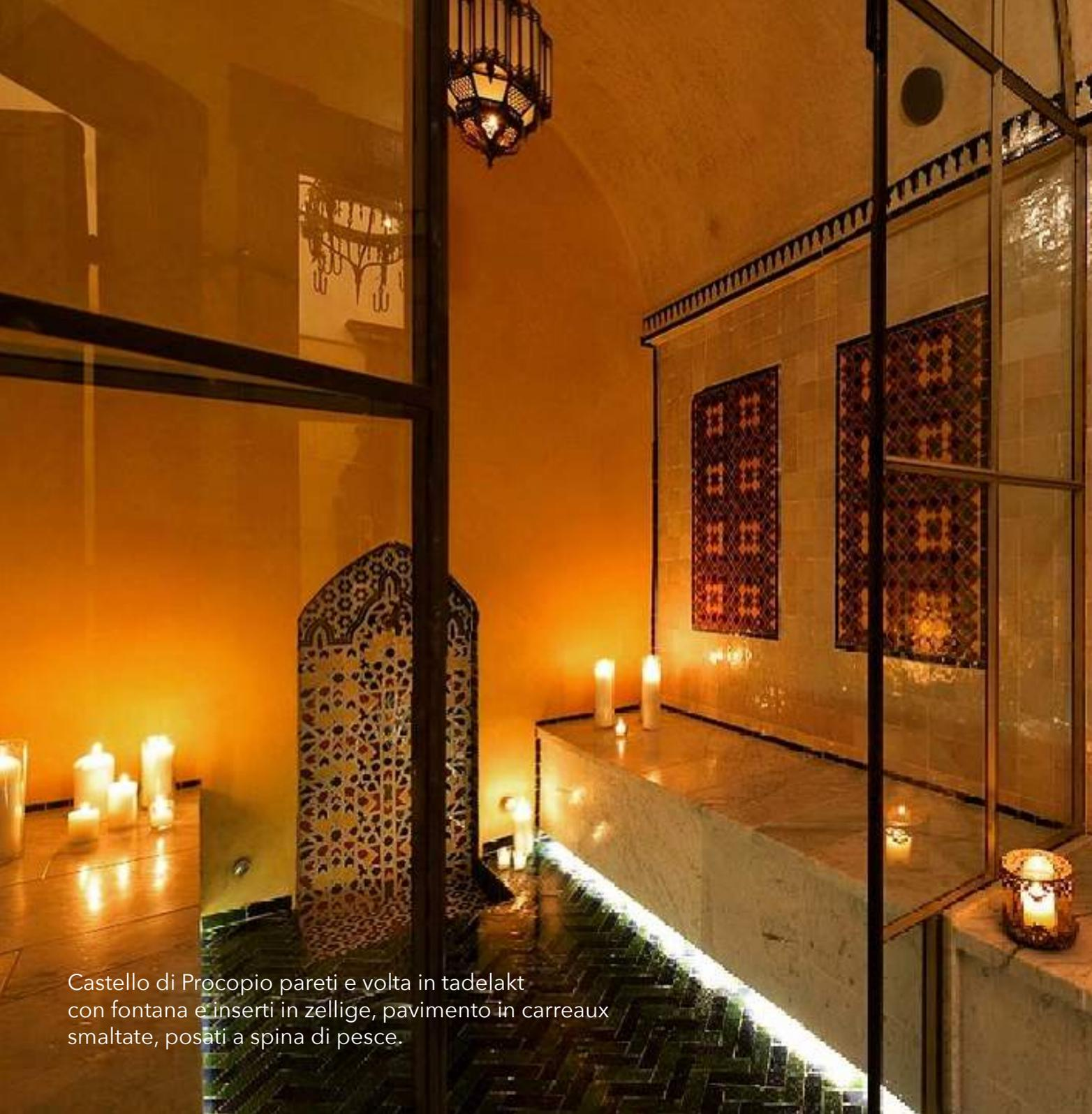
Castello di Procopio pareti e volta in tadelakt con fontana e inserti in zellige, pavimento in carreaux smaltate, posati a spina di pesce.
